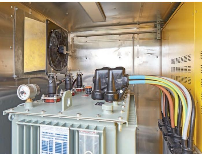
Zusätzliche Kühlung für warme Tage durch aktive Ventilation, ausgelegt auf der Grundlage einer numerischen Simulation.
