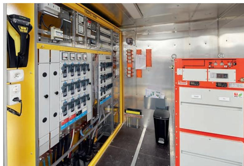
Niederspannungs-Schaltgerätekombination nach SN EN 61439-5, ECOS-C Mittelspannungsanlage SF<sub>6</sub>-frei
